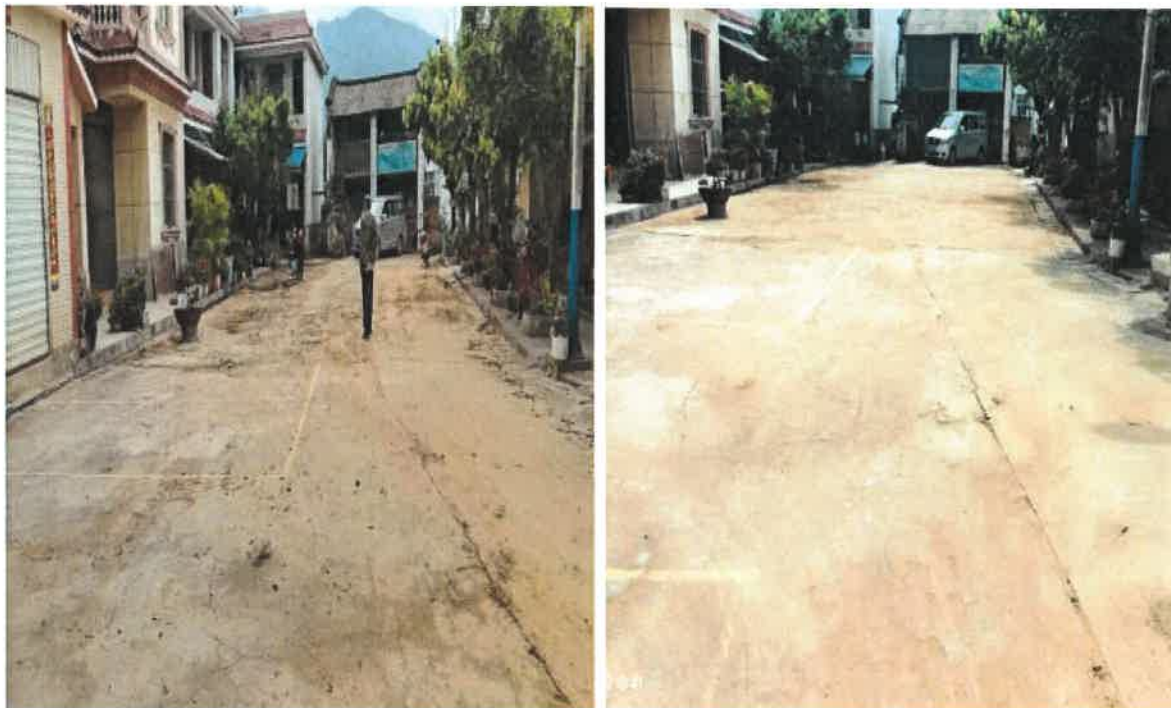
光华村旧村自然村整改前后照片：
