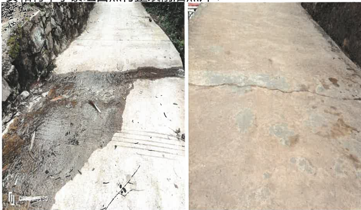
安和村平掌寨组自然村整改前后照片：
